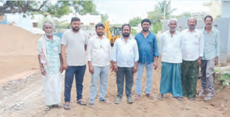
అమరచింత మండలంలోని మస్తీపూర్ గ్రామంలో సిసి రోడ్డు పనులు ప్రారంభం
